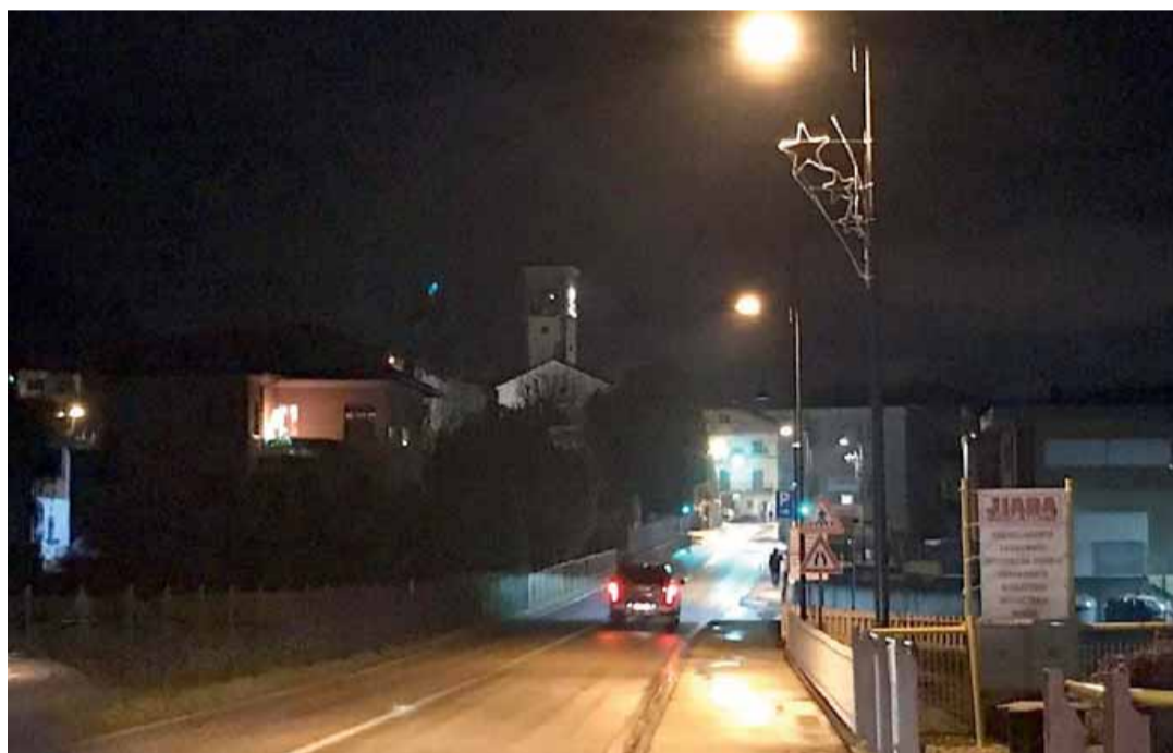
• Alcune delle luminarie a inizio dicembre, appena installate e in attesa di essere collegate, nell'area di Lodrone
