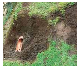
• Scavo e foro nel tubo per fare...
