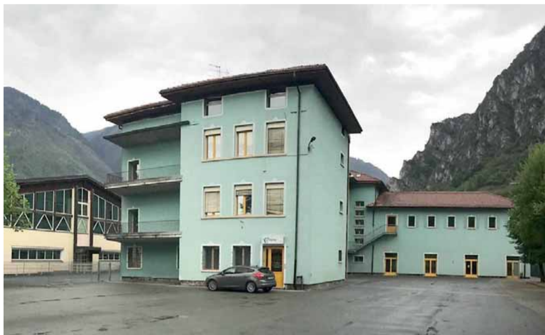
• L'edificio delle scuole elementari di Storo dovrà essere demolito e ricostruito
