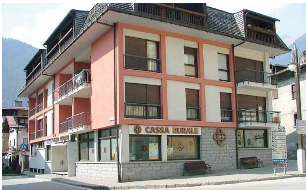
• La sede della Cassa Rurale di Pinzolo che presto porterà il nuovo nome: "Cassa Rurale Adamello"
