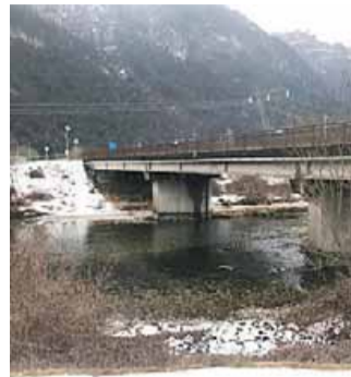
Il Ponte dei tedeschi sul Chiese
