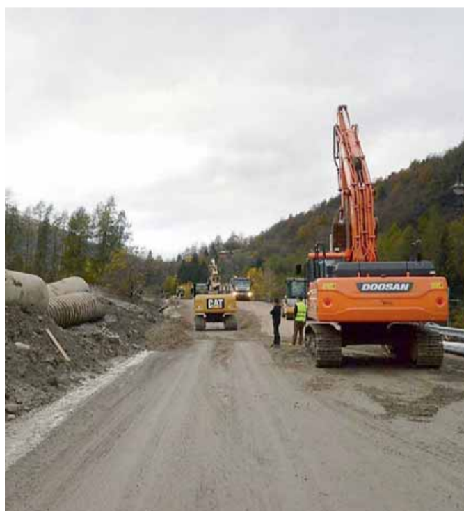
I lavori per il ripristino dei collegamenti a Dimaro
