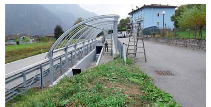
Lo scheletro in acciaio che riceverà la tettoia in policarbonato a Storo
