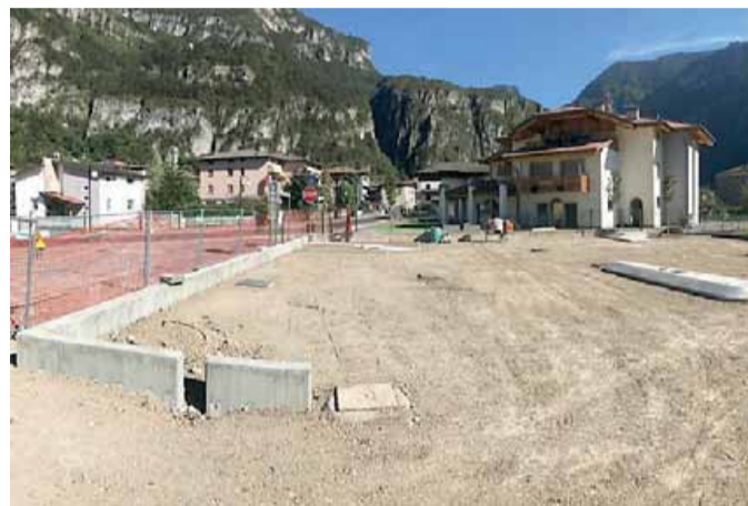
Il sedime del nuovo parcheggio in costruzione alle scuole medie di Storo
