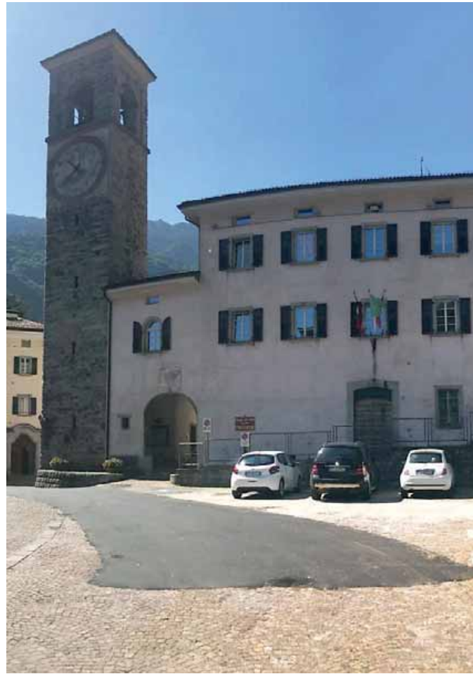
Lo strato di asfalto che fa bella figura di sé in piazza San Rocco a Condino
