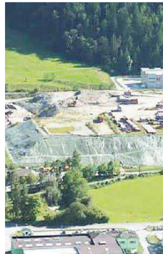
Zuclo, l'area per il biodigestore
